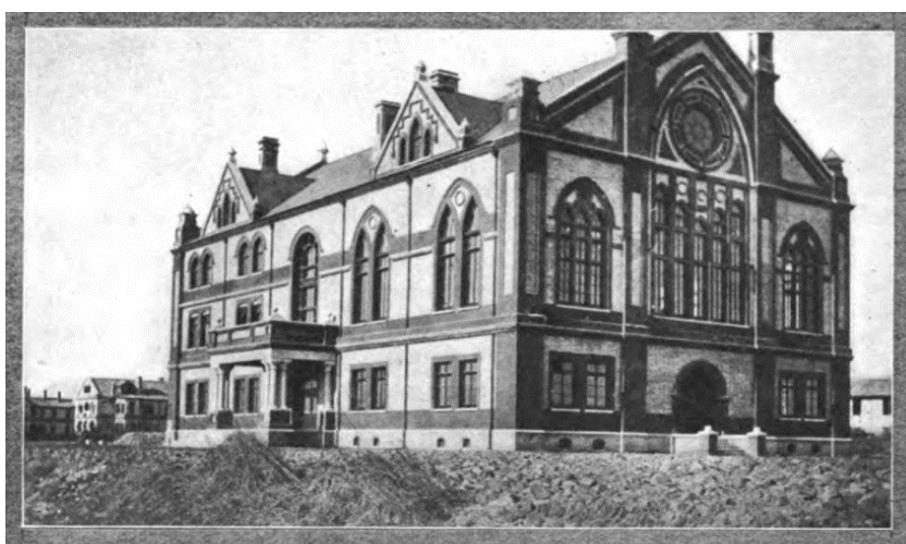
图 4.柏高德拍摄的竣工后的思晏堂
